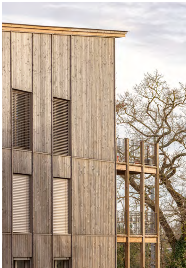
▲ Détail de façade.
